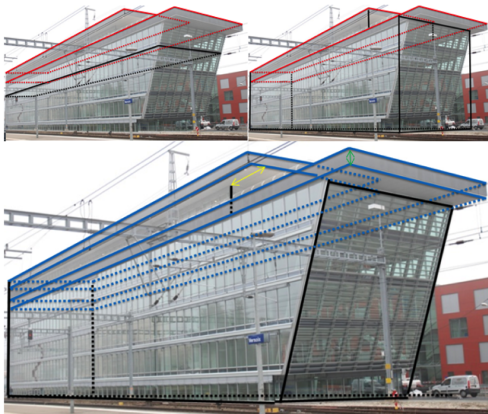
FIGURE 3: Exemple de façade non-verticale ; flèche verte = 1m, flèche jaune = 4m
