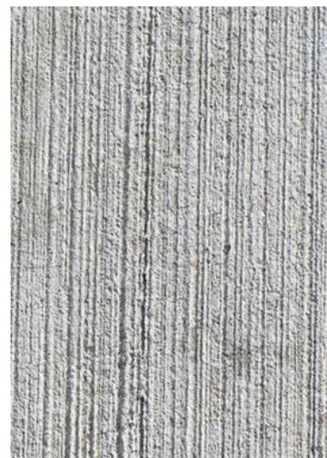
Revêtement placette 1: Imperméable, accessible PMR (ex.: béton désactivé ou dalle de béton balayé)
