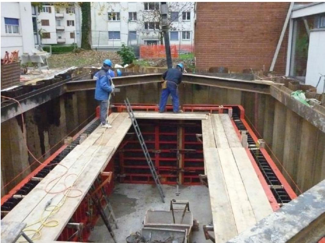
Exemple d'un accumulateur de glace de 75 m<sup>3</sup>. Projet d'une installation pilote à Rapperwil. Source : Institut für Solatechnik. *Saisonale Wärmespeicherung im Eisspeicher – Erste Erfahrungen mit einer Pilotanlage*. Présentation de D. Philippen lors du SPF-Industrietag 2013.
