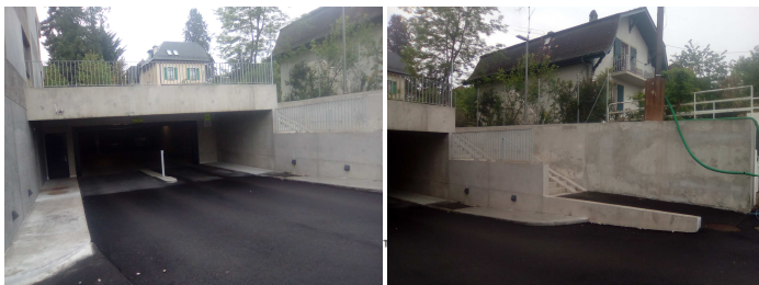
Trémie existante, accès et liaison au Parking C
