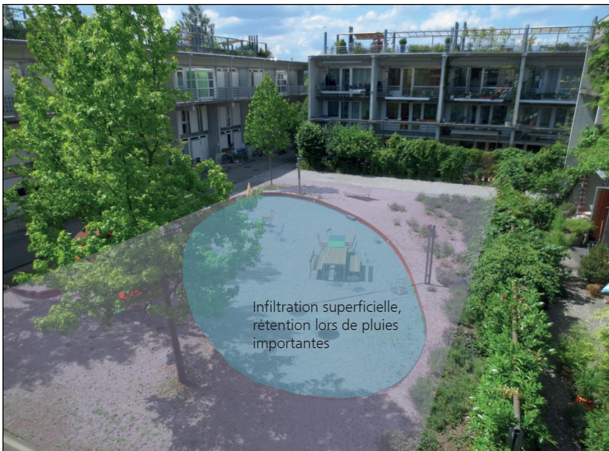
Figure 17 : Principe de rétention et d'infiltration (source VSA).
