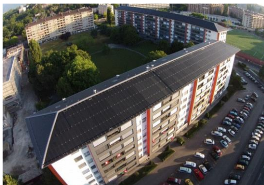
Figure 18 : Image de gauche immeubles de la Cigale avec toitures solaires, image de droite capteurs solaires sélectifs non vitrés sur toiture plate (MFW «Pauwmolen» en Pays bas: 160 m 2 capteur AS pour régénération & ECS) [24]
