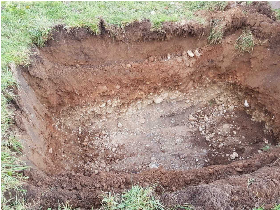
Figure 3 : Fouille n°2 avant le test d'infiltration
