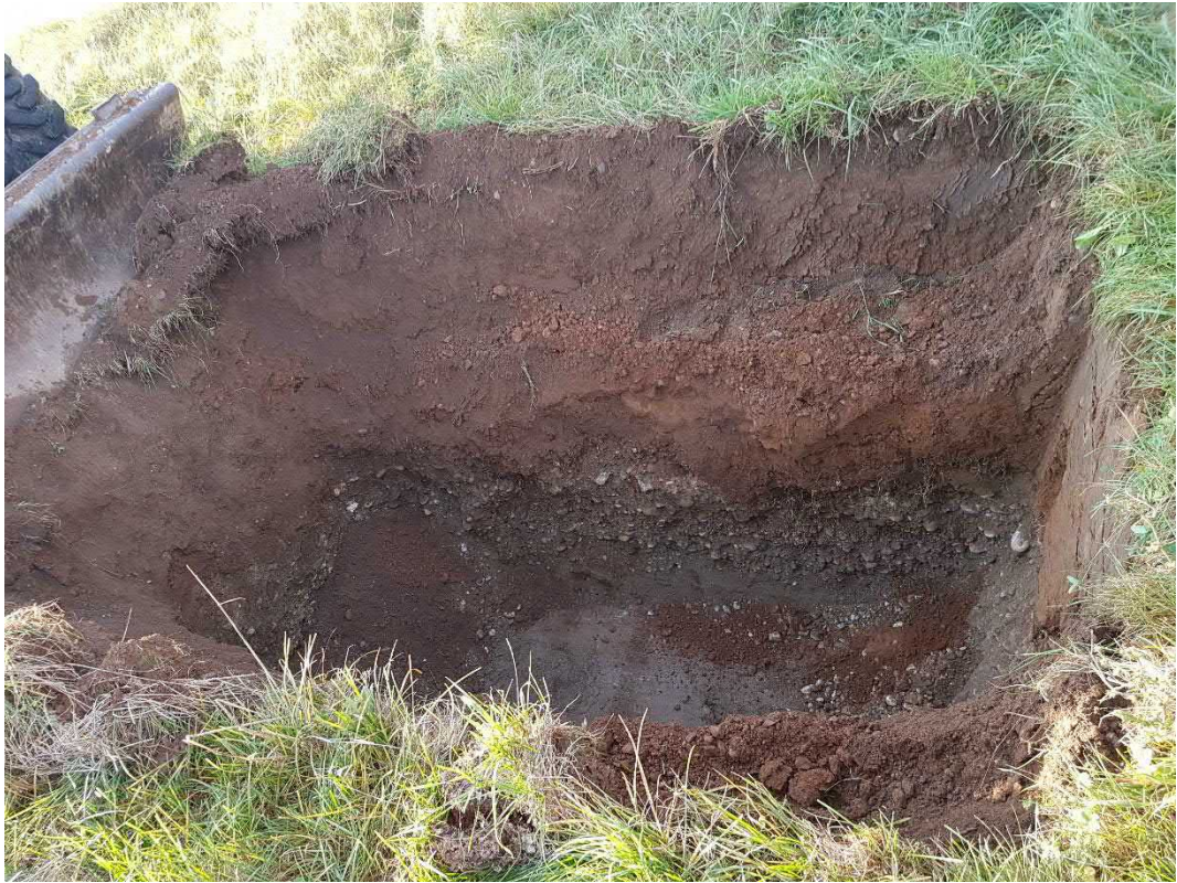
Figure 2 : Fouille n°1 avant le test d'infiltration
