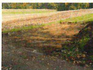
Aire d'installation de chantier préparée en décapant le sol (solution non recommandée).
