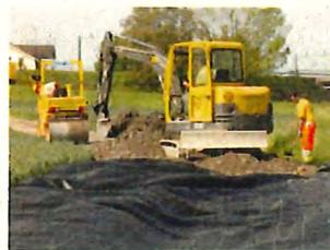
Mise en place d'une piste provisoire sur un géotextile.
