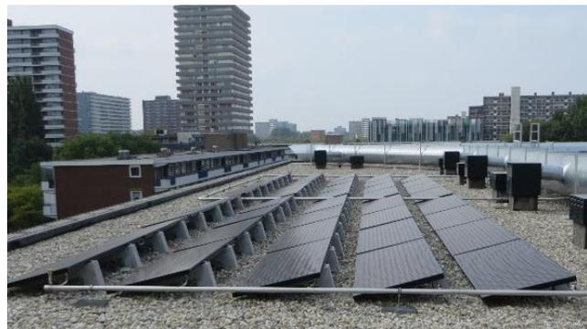
Figure 27 : Image de gauche immeubles de la Cigale avec toitures solaires, image de droite capteurs solaires sélectifs non vitrés sur toiture plate (MFW «Pauwmolen» en Pays bas: 160 m<sup>2</sup> capteur AS pour régénération & ECS) [24]
