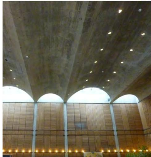
S.E. Møller, détail du dispositif d'éclairage intégré dans les voûtes 1/1°, mars 1963, gauche (COE)
