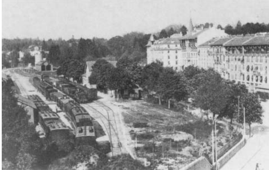
Figure 3: Photographie de la gare des Eaux-Vives au début du XXème siècle (SMS, 2004)
