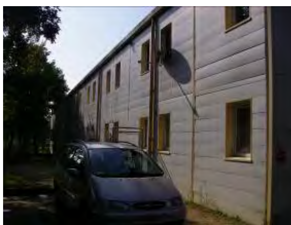
Figure 38 : Bâtiments sociaux en préfabriqué métallique
