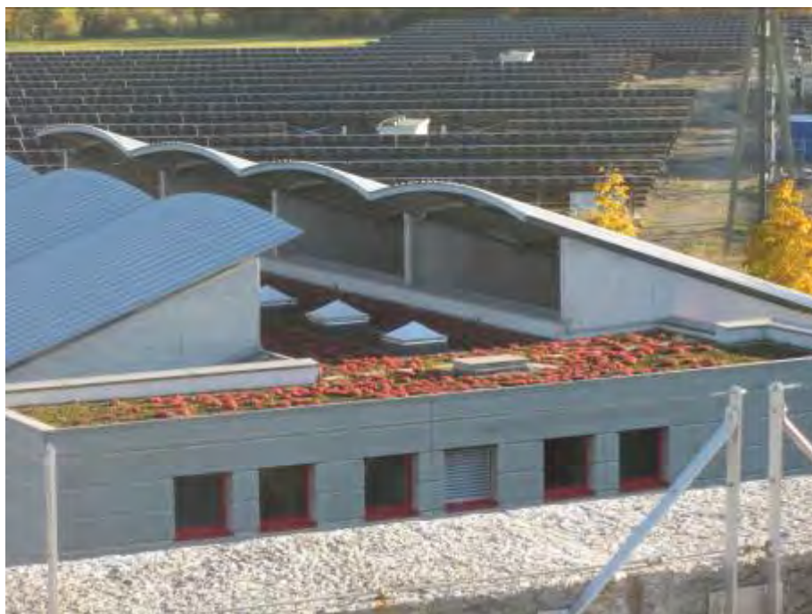
Figure 23 : Exemple de toiture végétalisée à Verbois (Ecotec, 2011)
