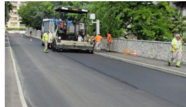
Figure 121: Réfection du revêtement bitumineux avec de l'enrobé phonoabsorbant sur le réseau routier cantonal 2013 (source: site web de la Ville de Genève, page "chantiers et travaux")
