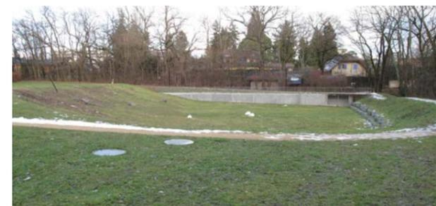
Figure 105: Exemple de bassin de rétention avec cheminement, Nyon
