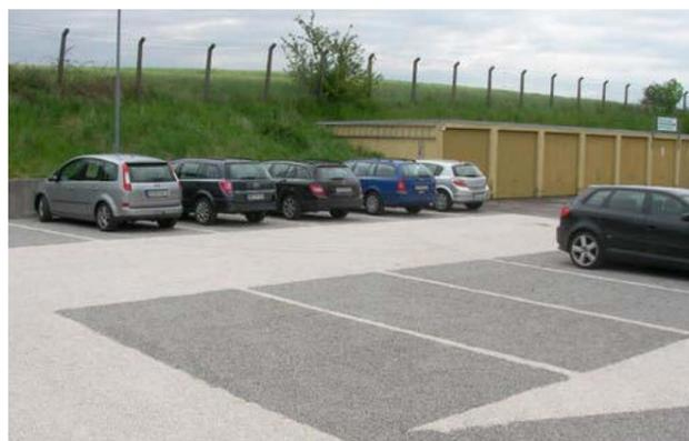
Figure 100: Exemple de stationnement en gravier argilo-calcaire
