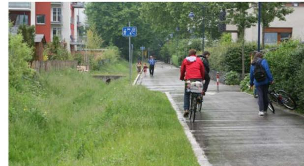
Figure 101: Exemple de noue le long d'un cheminement
