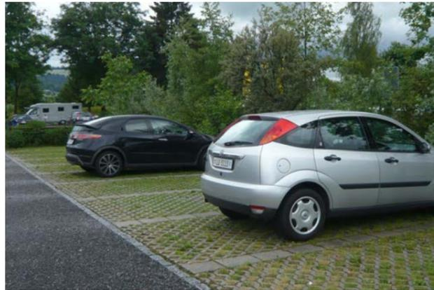
Figure 97: Exemple de stationnement en grilles gazon
