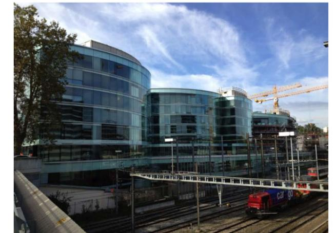
Figure 122: Bien que situé entre les voies de triage de Sécheron et l'avenue de France à fort trafic, le bâtiment de la Maison de la Paix jouit d'un silence intérieur impressionnant grâce à une façade double peau.
