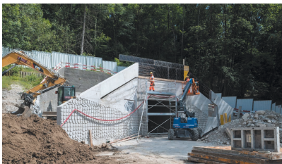
TUNNEL DE PINCHAT – Sortie de secours du Stand-de-Tir
