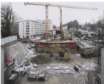
Tranchée couverte GRADELLE - Construction du cadre du pont sur la Seymaz
