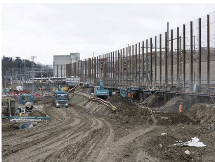
Gare de LANCY-PONT-ROUGE - Terrassement et construction des murs de soutènement provisoires
