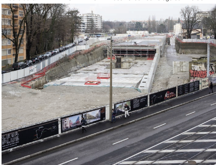
Gare de GENÈVE-EAUX-VIVES - Fin des travaux de l'étage commercial
