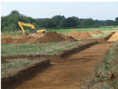
Figure 12 : Illustration des phases de décapage et de remise en état des sols.
