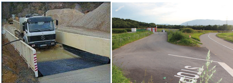
Figure 9 : Mesures de réduction des poussières.
