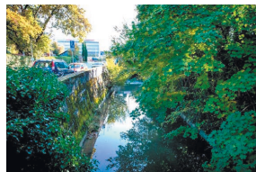
L'Aire canalisée à l'Etoile (avant l'entrée en galerie)
