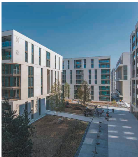
Cour intérieure - chemin des Mérinos 8 à 14
