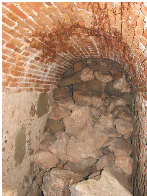
Obturation ancienne du souterrain sous la rue François-d'Ivernois
