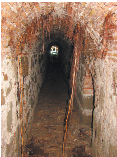
Galerie majeure, vue en direction de la rue de l'Athénée
