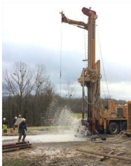
Forages de contrôle Profondeur (-30 à -800 m)
