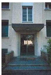
Façade nord, détail de l'entrée
