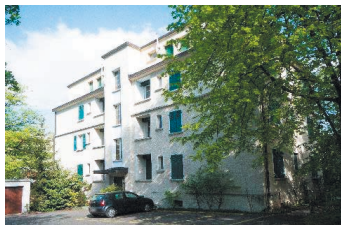
Façades nord et ouest
