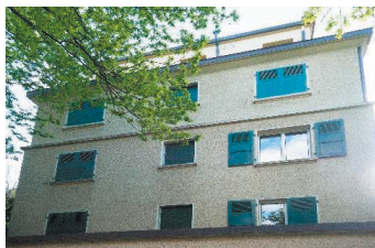
Façade est, détail
