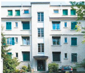
Façade nord, détail de baies, entrée
