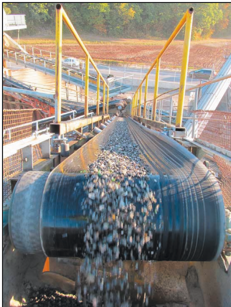
Fig. 5: Lavage des mâchefers sur l'installation de Soreval SA au Bois-de-Bay.
