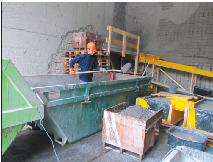
Figure 2: Installation de lavage et récupération des métaux denses par gravimétrie construite pour le premier test de 2017.
