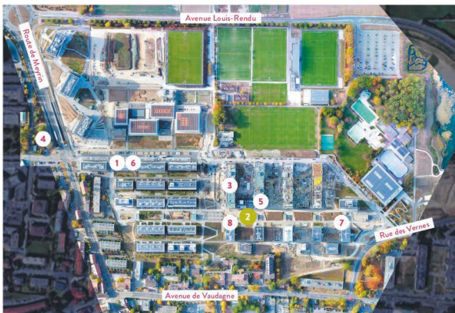
Photo aérienne du quartier des Vergers avec une partie des bâtiments en construction en Novembre 2018.
