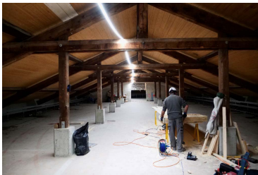
Chantier du nouvel Hôtel des archives septembre 2022
