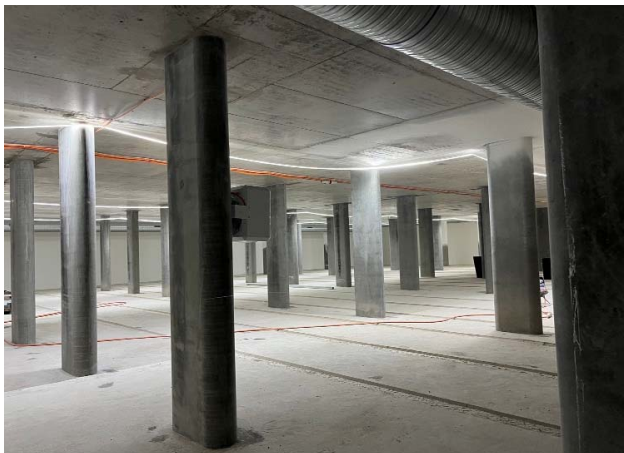
Chantier du nouvel Hôtel des archives septembre 2022
