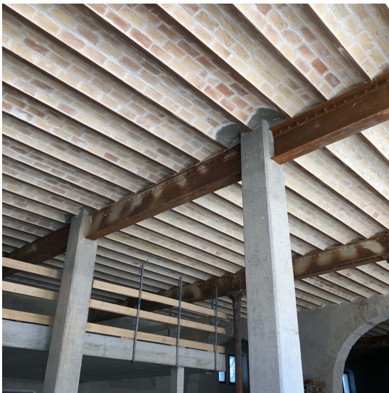
Chantier du nouvel hôtel des archives septembre 2022
