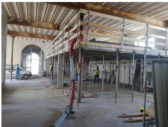
Chantier du nouvel Hôtel des archives mars 2022
