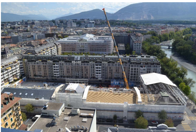
Chantier du nouvel Hôtel des archives septembre 2022
