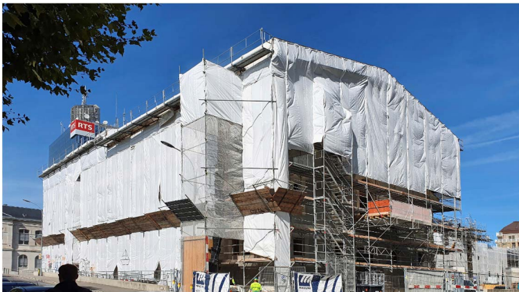
Chantier du nouvel Hôtel des archives septembre 2022
