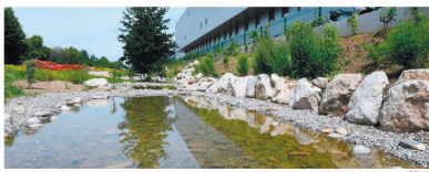
Des solutions existent: La noue pluviale de Meyrin attire des libellules dans la zone industrielle
