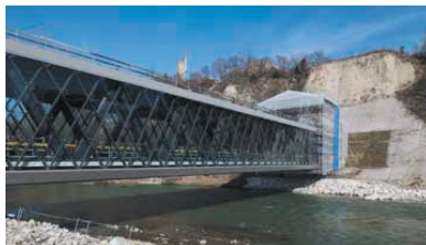
PONT SUR L'ARVE – Pose du vitrage
