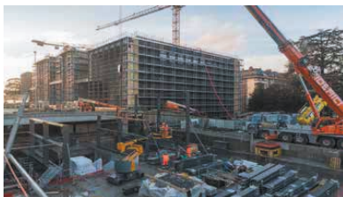
GENÈVE-EAUX-VIVES – Montage de la charpente métallique de l'urgence centrale (Au deuxième plan : les travaux de la Nouvelle Comédie de Genève)
