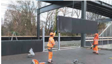
PONT SUR LA SEYMAZ – Pose des parois anti-bruit
