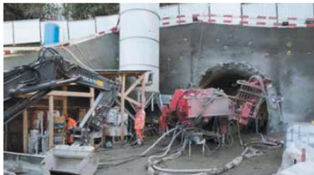
**CAROUGE-BACHET** – Au-dessus du tunnel de Pinchat, les travaux de creuse de la galerie d'évacuation de la sortie de secours du Tir-au-Canon ont débuté.
