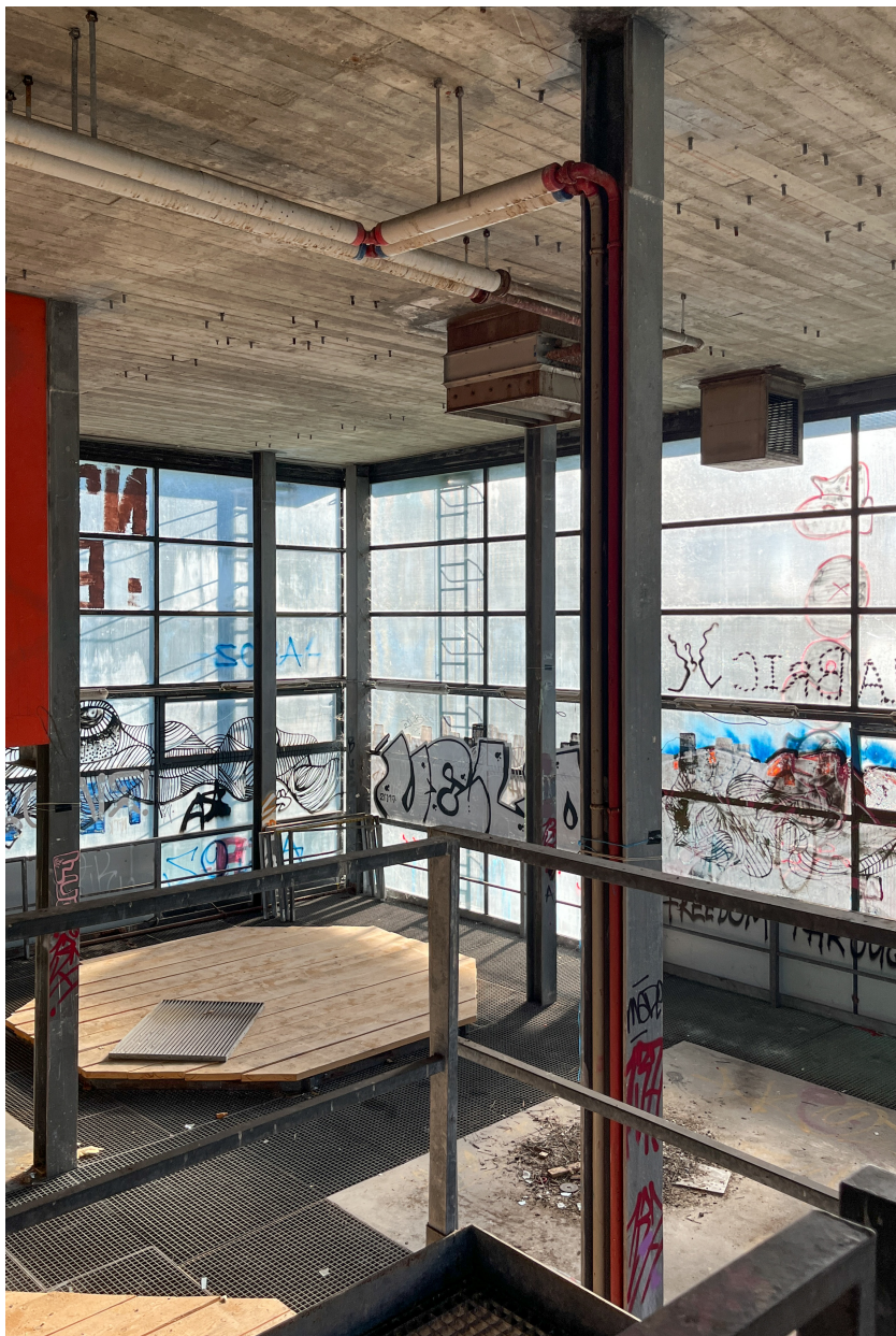
Fig. 18 - Espace de la verrière (2023)
