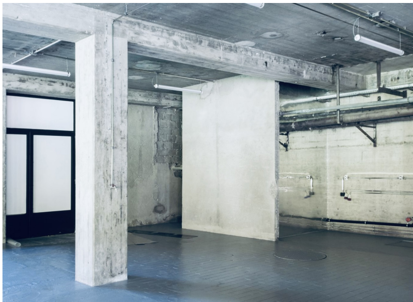
Fig. 20 - Vue du premier espace transformé après travaux (2023)
