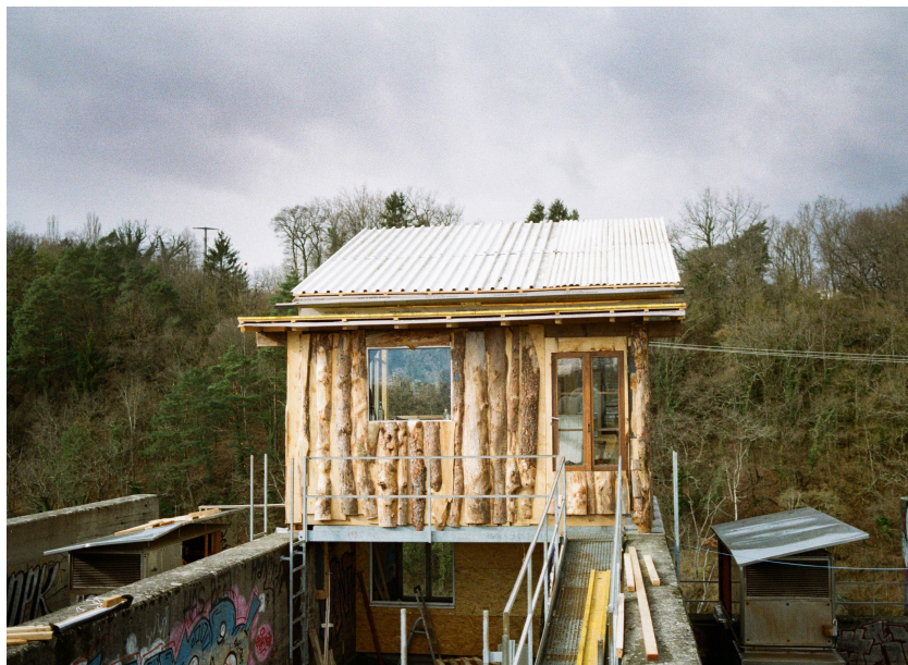
Fig. 31 - Cabane sur la toiture construite durant l'occupation (2018)
