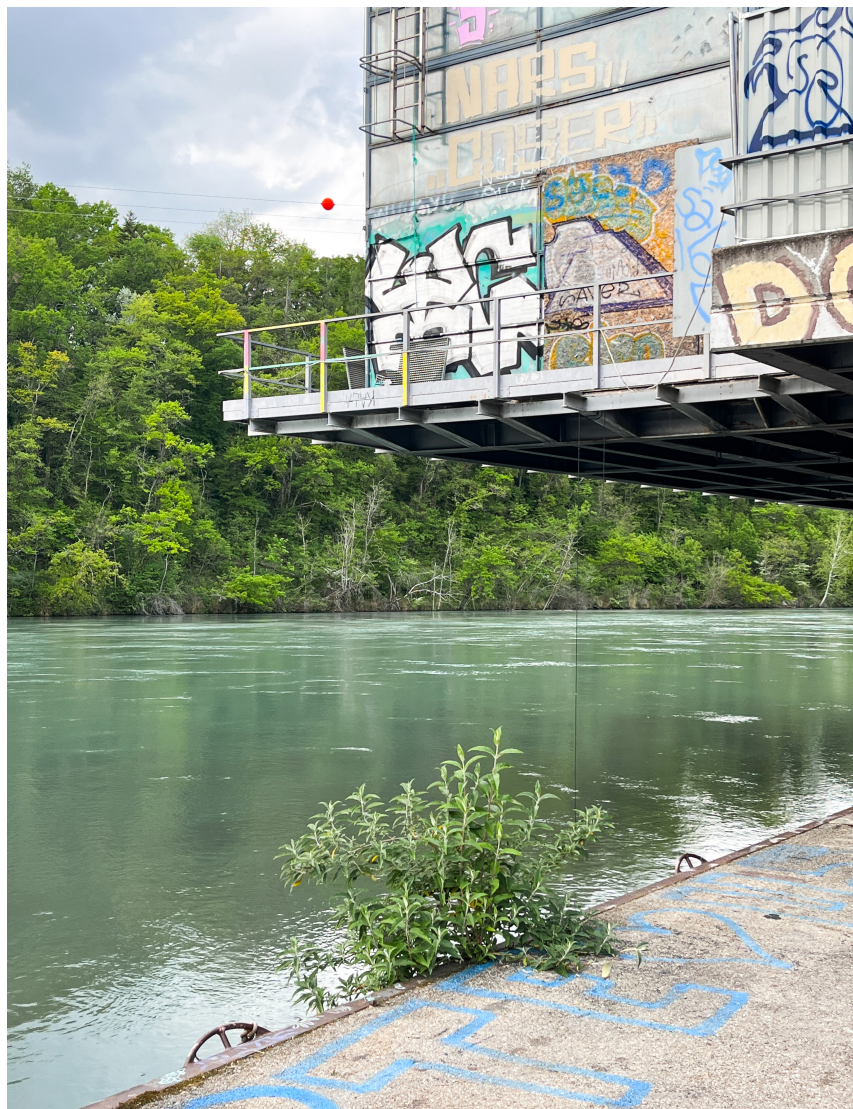
Fig. 26 - Vue du bâtiment et des rives du Rhône depuis le quai sud (2022)
