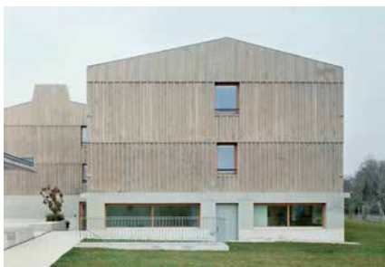
Centre de Chevrens - Bâtiment Habitation
