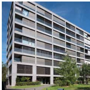
Immeuble La Forêt
