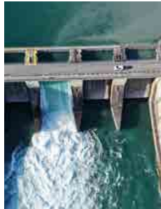
Barrage de Verbois
