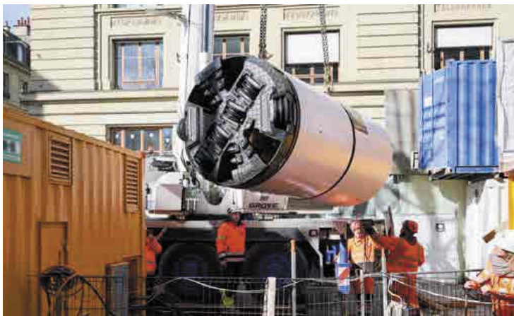
Microtunnelier au Quai de la Poste
