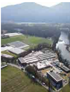
Station d'épuration de Villlette
