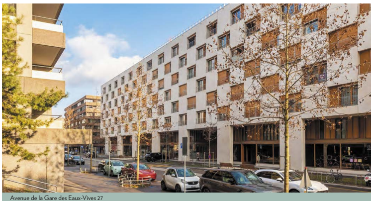
Avenue de la Gare des Eaux-Vives 27
