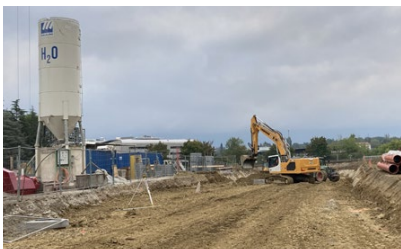
Chantier des infrastructures de l'écoParc des Cherpines
