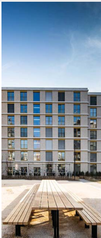
Cour centrale de l'étape 2 du quartier de Pont-Rouge, Lancy
