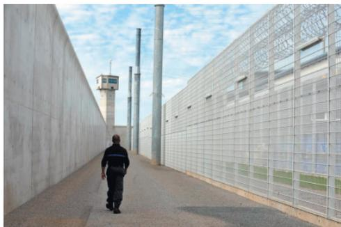
Figure 3 Exemple de mur, chemin de ronde et clôture type sécurifor
