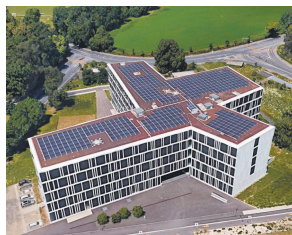
École de Commerce Raymond-Uldry Végétalisation & Photovoltaïque
