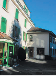
Façade rue du Couchant
