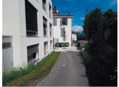
Façade rue du Couchant
