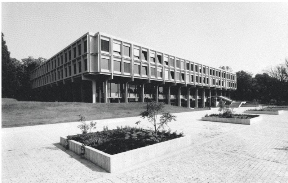
La construction originale a été conçue sur un principe de préfabrication béton avec un système porteur principal composé de poteaux et poutres.
