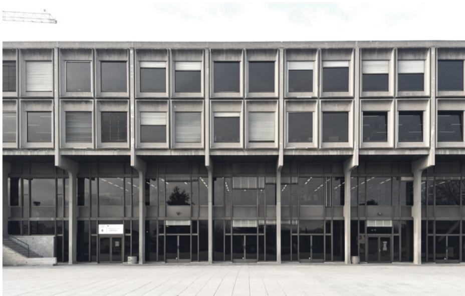
L'enveloppe, composée d'éléments préfabriqués en béton (non ou peu isolés) et de menuiseries extérieures en aluminium.
