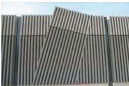
*Béton absorbant (béton de lave)*
