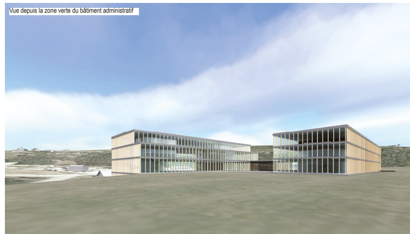
Vue depuis le chemin interne des trois bâtiments avec la salle multi-usages au centre de l'image
