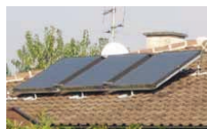
Pose en adjonction des installations de panneau solaire sur console: — Intégration mauvaise — Impact visuel important, pour un gain d'efficacité très faible — Défavorable à l'entretien
