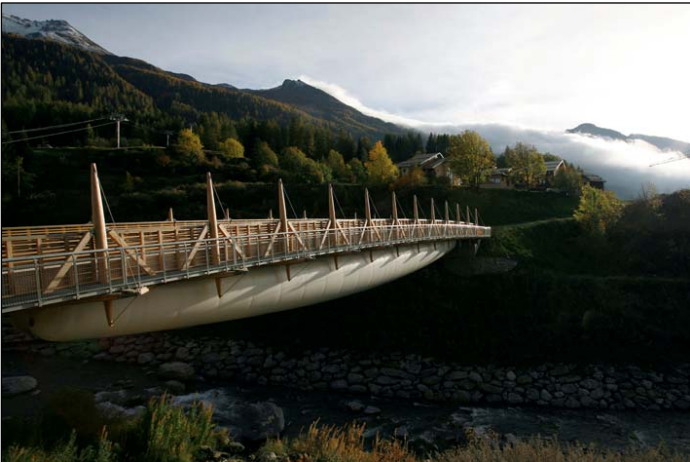
Ethno-passerelle : structure stabilisée avec des membranes à air comprimé
