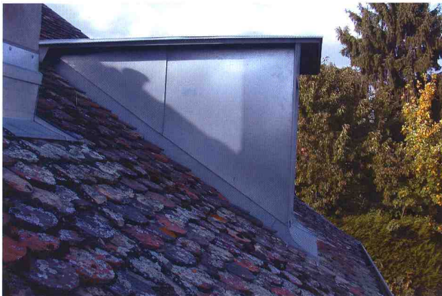
Toiture en tuile plate
