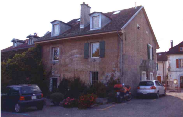
Façades Est et Nord Toit avec lucarnes et fenêtres de toiture
