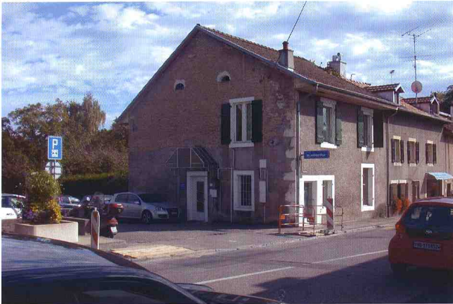
Façades Nord et Ouest Entrée avec sa marquise en métal
