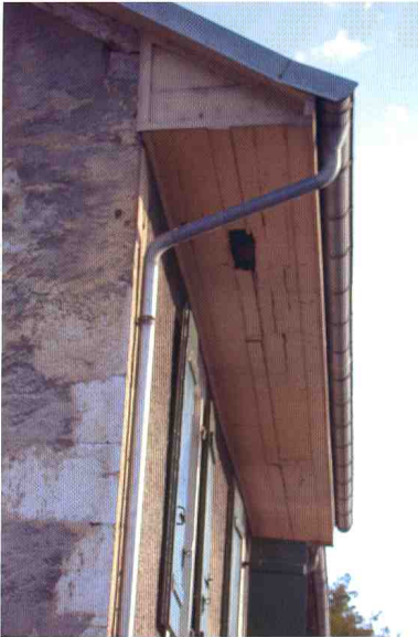
Plafond de l'avant-toit à rénover
