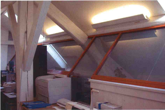
Grand bureau des combles à l'Ouest avec élément de séparation en verre et en métal
