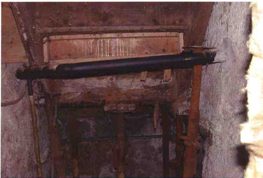
Escalier menant au premier étage supporté par des pointelles
