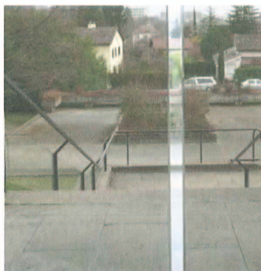
Espace entre les deux battants
