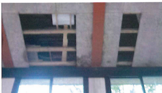
Le plafond de la salle de gym.
