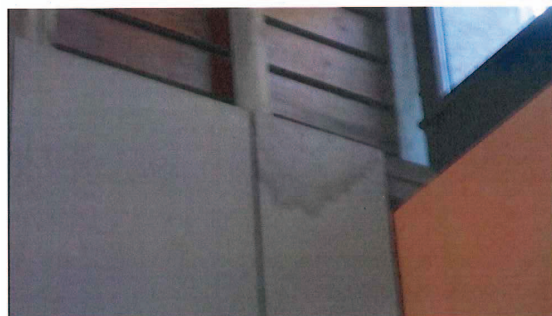
Taches d'infiltration.
