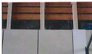
L'isolation derrière la paroi.
