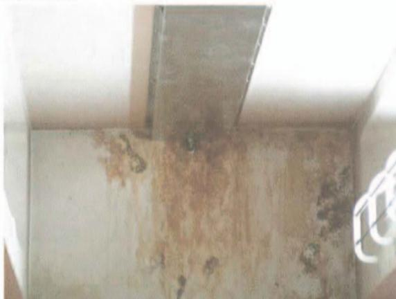
Les prises électriques du mur du fonds ont été condamnées en raison de l'humidité excessive du mur.
