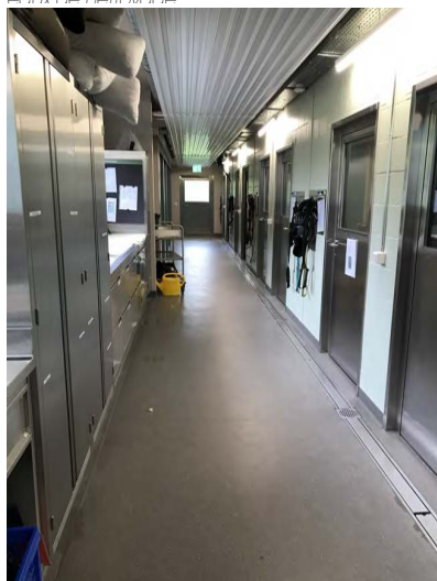
7. Couloir de distribution des box intérieurs Intégration de stations de travail dans les couloirs, chauffage au plafond, écoulements linéaires au sol, crochets pour accessoires.
