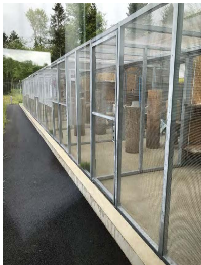
5. Enclos extérieurs pour chats Détail de bordure de béton à la jonction des aménagements extérieurs pour contenir les eaux de nettoyage
