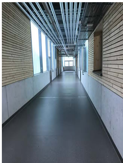
3. Couloir de distribution central non-chauffé Distribution des techniques par le plafond
