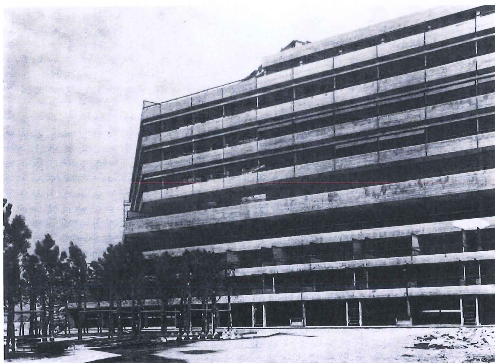
Unité résidentielle de Forte di Quezzi à Gênes de Daneri (en haut et au centre à gauche), complexe du Cap noir à Ospedaletti de Daneri (au centre à droite et en bas) © Catalogo Bolaffi dell architettura italiana, 1963-1966
