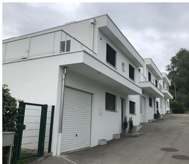
Construction récente (Soral 10) sans arborisation
