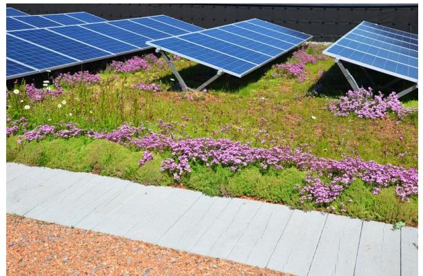
Figure 7: toiture végétalisée (source : Google)
