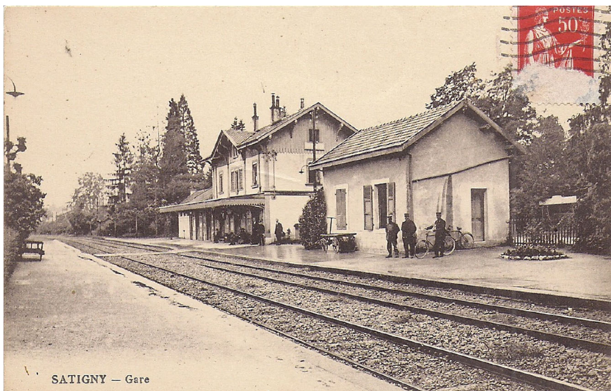
Fig. 14 : Carte postale de la gare de Satigny et du bâtiment de service
