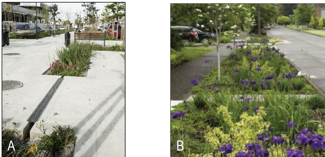
Figure 4 Exemples de caniveaux et de noue (source OCEau).
